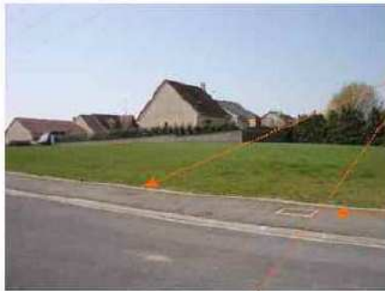
Chambre de desserte locale (lotissement) dédiée à France Télécom
