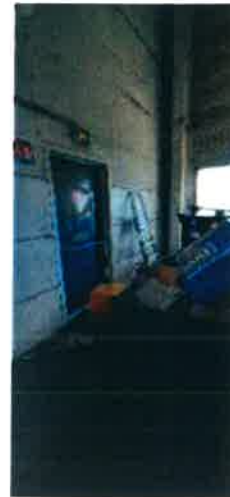
Issue de secours encombrée
