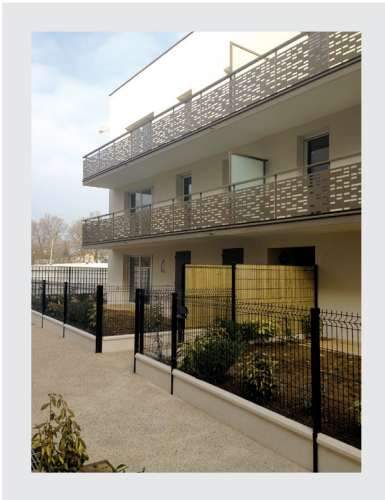
Logements en accession aux Joncs-Marins.
