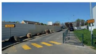
Afin d'assurer la sécurité des piétons, rue du CNR, durant la construction de la nouvelle école, un cheminement piéton protégé par des barrières a été réalisé fin mars aux abords du chantier.
